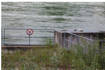
BU: Absperrmaßnahmen der RADAG bei Dogern
