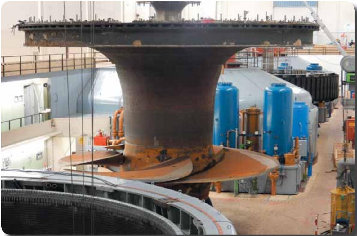
Blick von der Gallerieebene in das Saugrohr bei ausgebautem Maschinensatz
