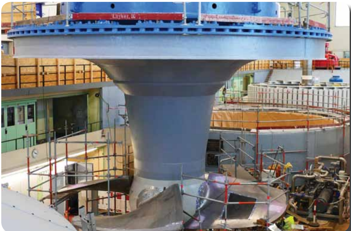
Turbineneinheit während der Remontage „Retrofit“ Maschine 2
