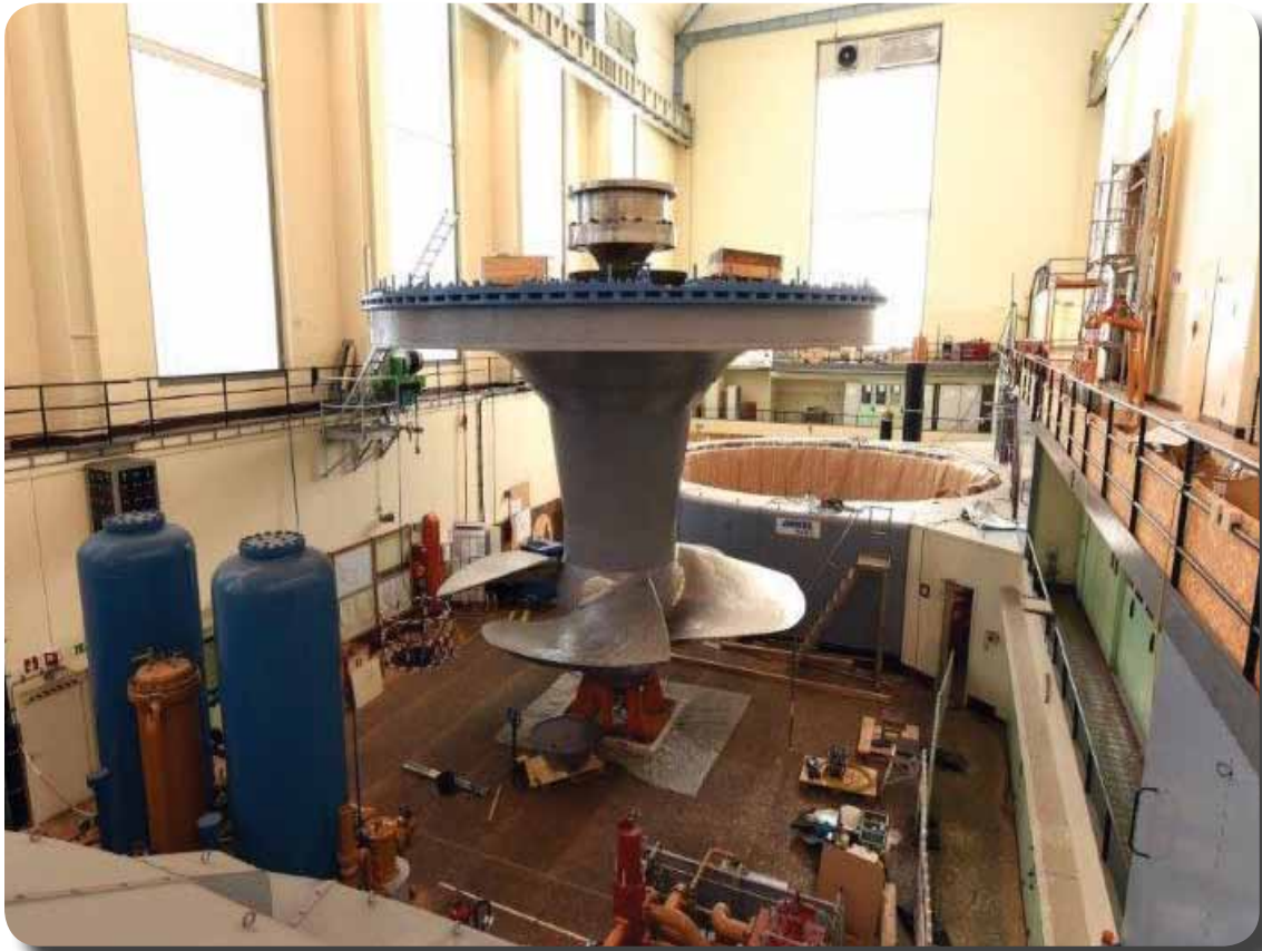
Turbineneinheit während des Einhebens (Retrofit Maschine M3)
