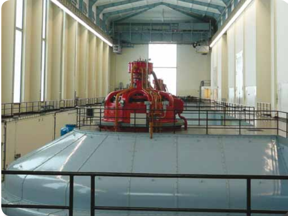
Maschinenhaus in Albruck
