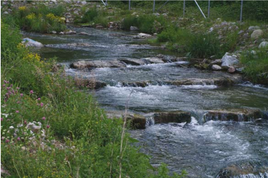
Fischaufstiegshilfe an der Altanlage
