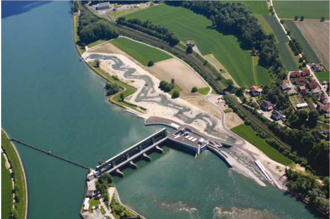
Blick auf das Umgebungsgewässer am Wehrkraftwerk
